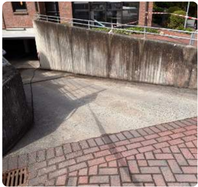
Foto 3 · Fläche C, Betonwand
